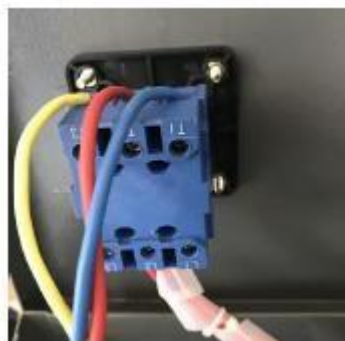
Подключение входящего силового провода
